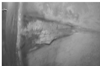
写真-4 左側壁映像例
