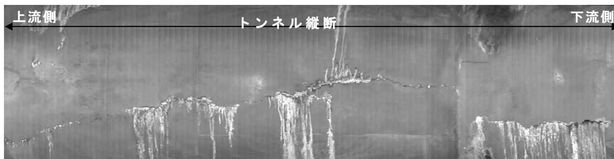
写真-8 天井カメラ展開画像作成例
