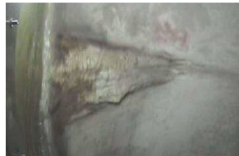
写真-4 左側壁映像例
