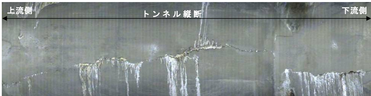
写真-8 天井カメラ展開画像作成例
