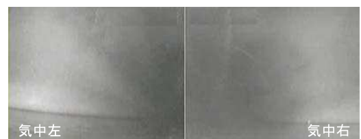
図-4 気中映像 (水路幅 約 2m 水面から天井 約 2m)
