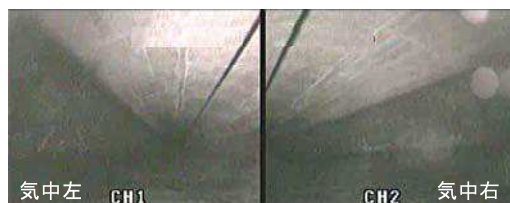
図-3 気中映像 (水路幅 約 2m 水面から天井 約 1m)
