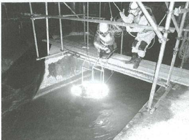
写真-3 船型カメラ投入状況
